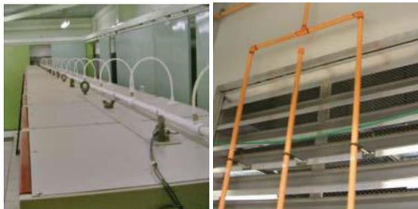
Figura 14 - Deteção por aspiração em grelhas de ventilação e bastidores
